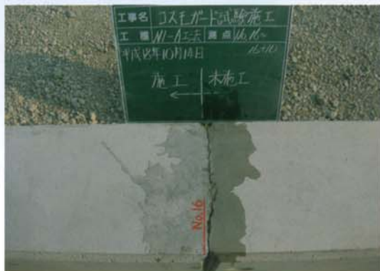
散水による吸水防止性比較写真
