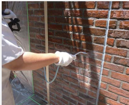
低圧噴霧器での施工
