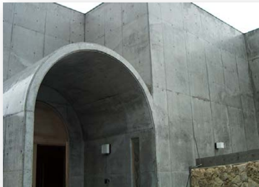
コンクリート打ち放し仕上げ建物
