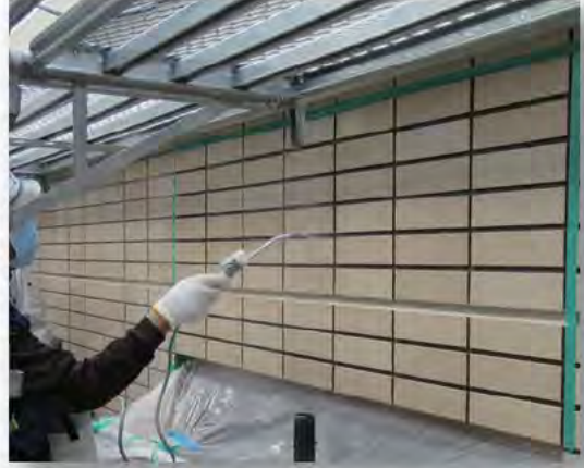
低圧噴霧器での施工
